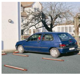
Afmærkning af p-båse - med bjælker eller med striber på asfalt
